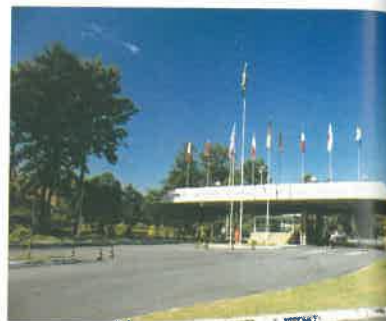
Fachada do INPE em São José dos Campos.
